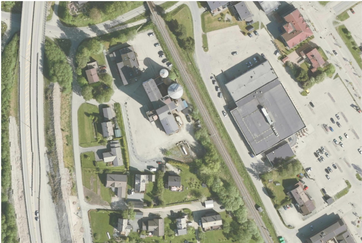
Figur 1 Oversiktsbilde Melhus kornsilo
